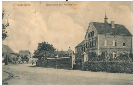
155/ Hammertor m. Krankenhaus 24.10.1914
